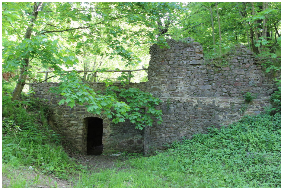
Hrad Fulštejn, vstupní koridor s mostem.
