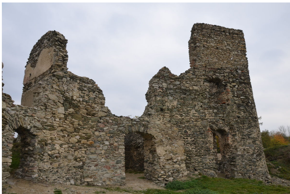
Pohled z nádvoří na budovy paláce.
