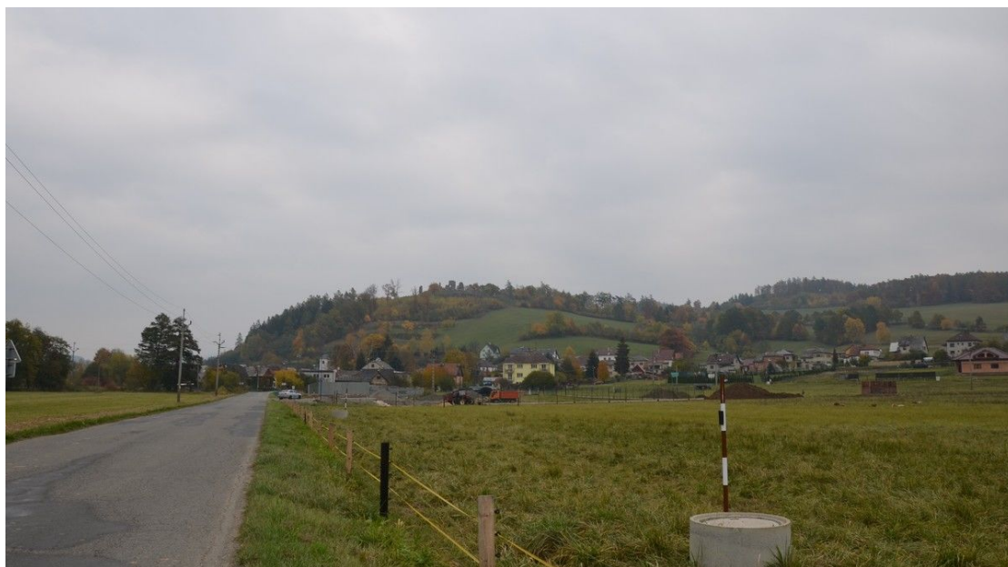
Celkový pohled na hrad od jihozápadu.
