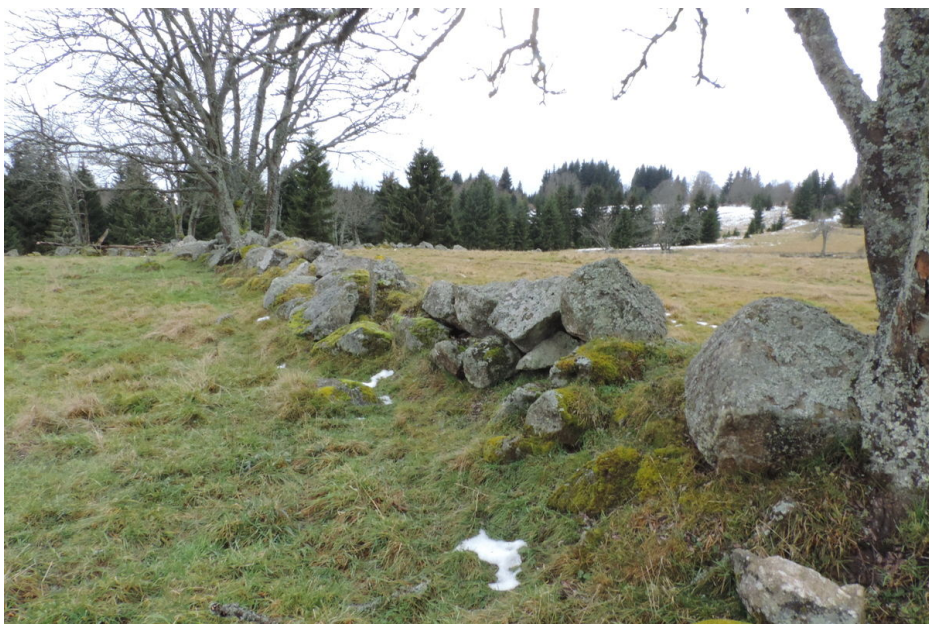
Detail mezního pásu z mohutných balvanů.
