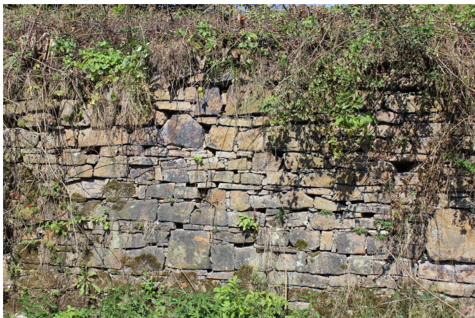
Detail stěny kontraeskarpy opevňovacího příkopu v severní části pevnosti.
