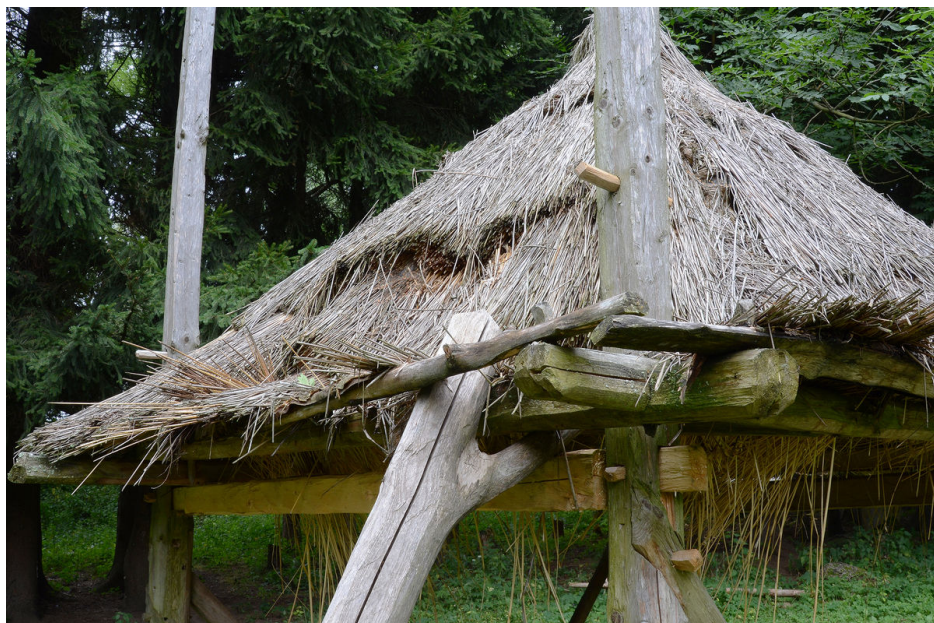
Oboroh. Detail konstrukce střechy.
