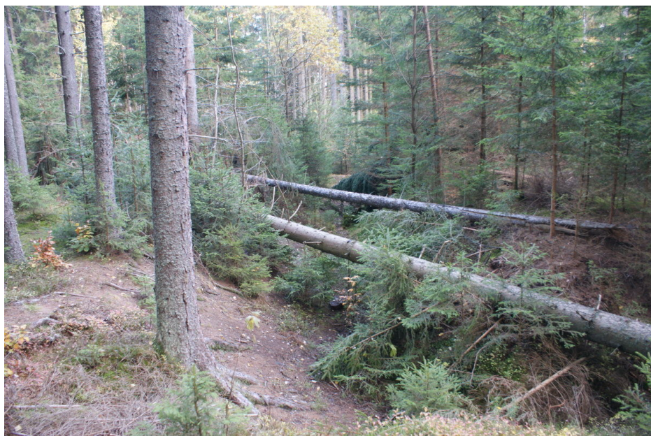
Opevnění poškozené lesním polomem.
